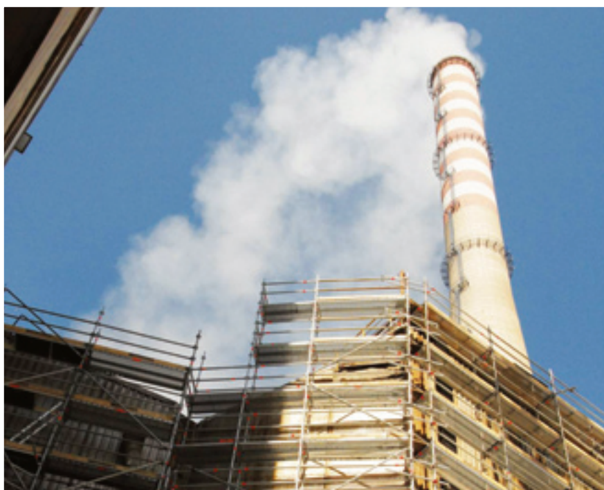
Ускоро почиње изградња новог блока: Термоелектрана Костолац Б
