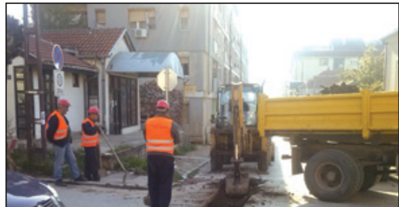
Санација водоводне мреже
